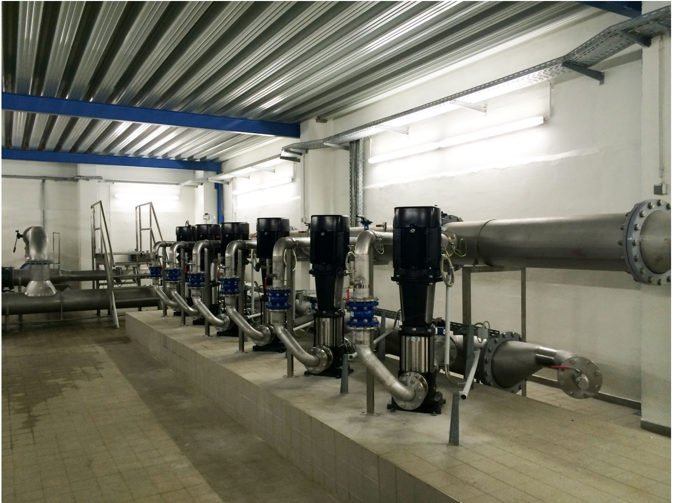
Anlagenbau - Druckerhöhungsanlagen
