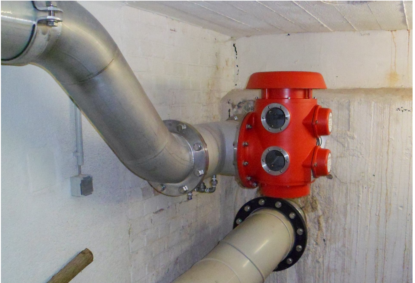
Anlagenbau - Wasserspeicher Anlagenbau - Wasserspeicher
