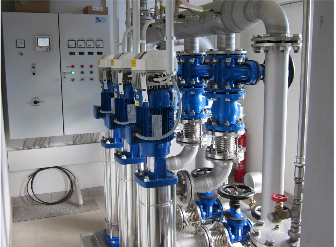
Anlagenbau - Druckerhöhungsanlagen
